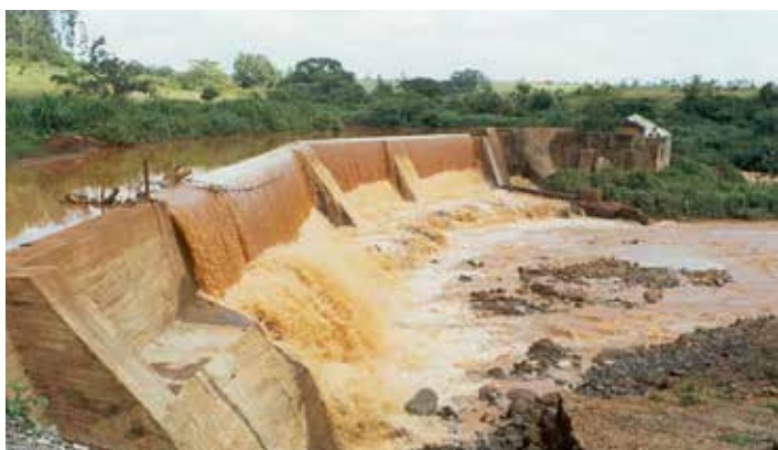
Costruzione di dighe sul fiume Thika, Kenya 1999.
