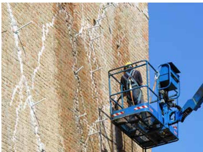
Lavori di messa in sicurezza del mastio
